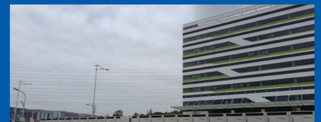
东莞理光创想项目 3.8MW/7.6MWh
